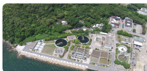
西貢 污水處理廠
