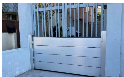
西貢南圍的可拆卸式擋水板
