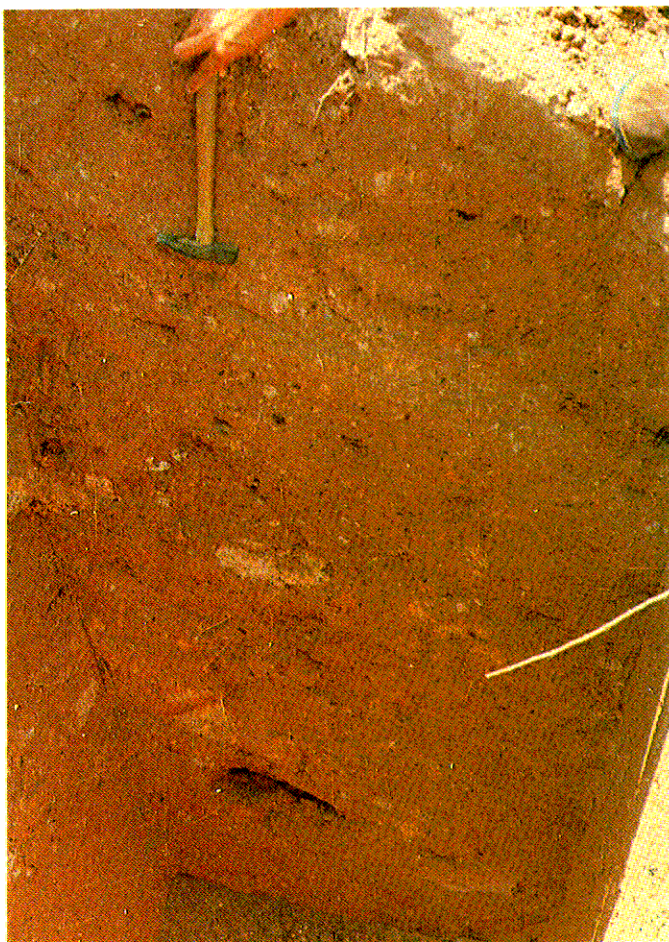
照片圖 1.13 - 土層平行於斜坡 的花崗岩質填土
