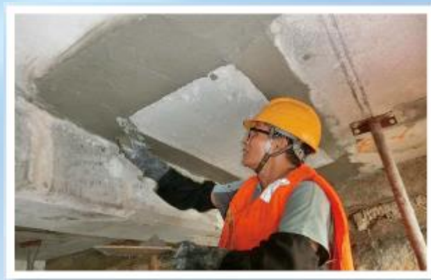
修補碼頭承台結構底部
