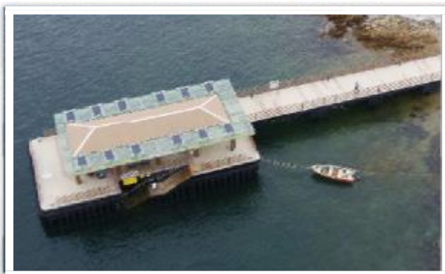
橋咀碼頭重建工程
