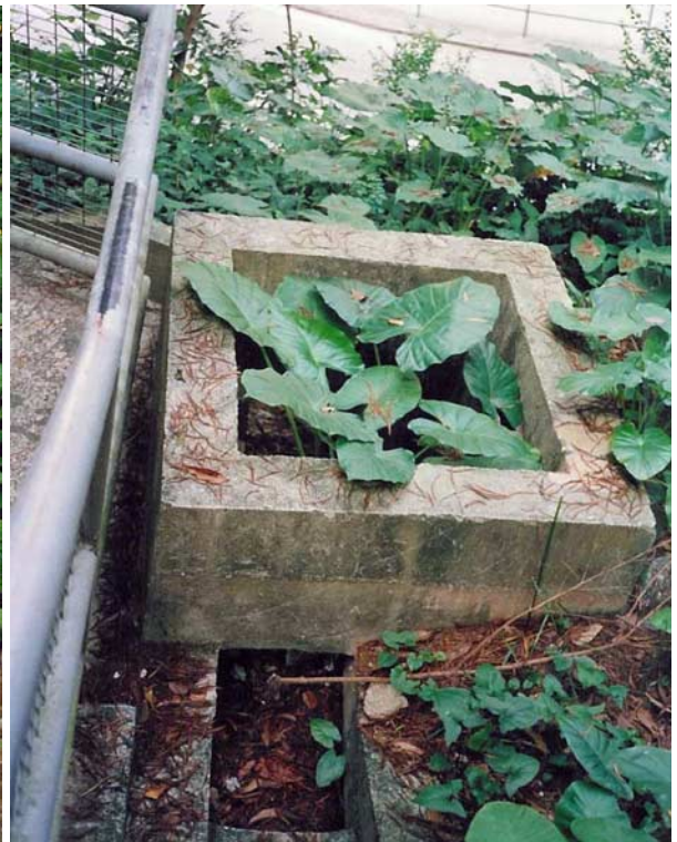
(4) 坡頂的集水井
