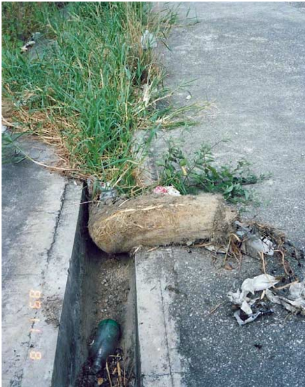
(1) 坡頂的 U 形排水渠
