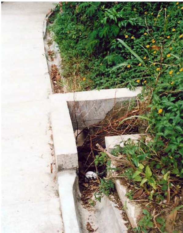
(3) 坡腳的集水井
