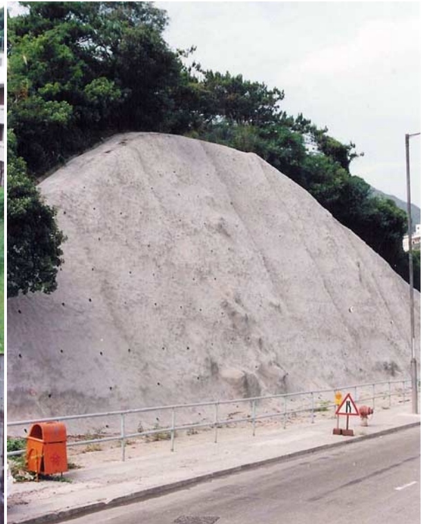
(2) 噴漿混凝土護面
