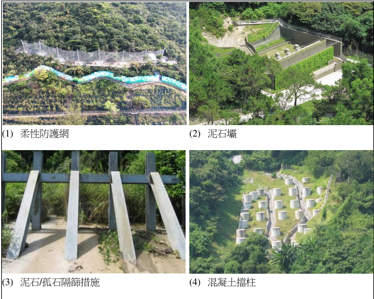
圖片 6.1 天然山坡災害緩減措施
