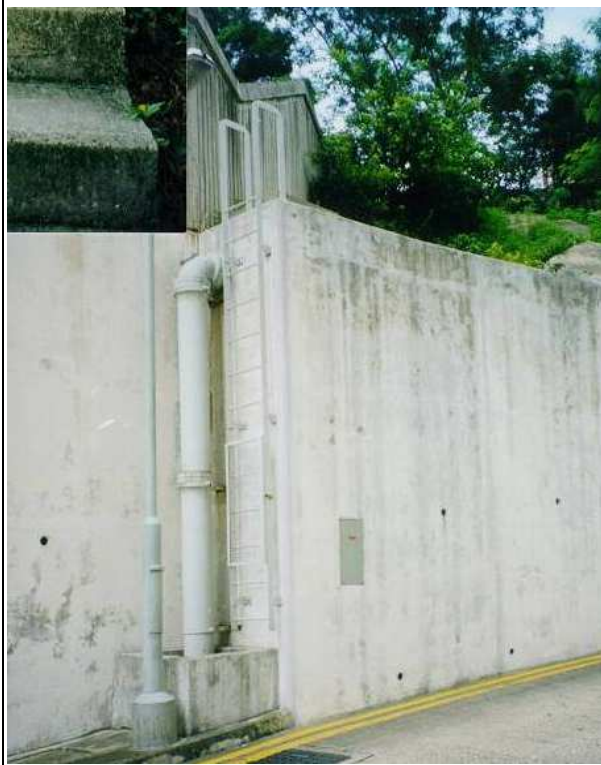
(1) 鋪設在擋土牆外的排水落管
