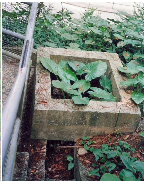
(4) 坡頂的集水井
