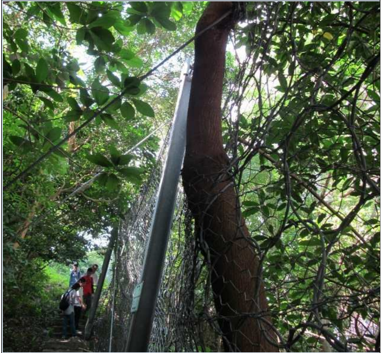
圖片 7.2 於柔性防護網主網上混生的樹木
