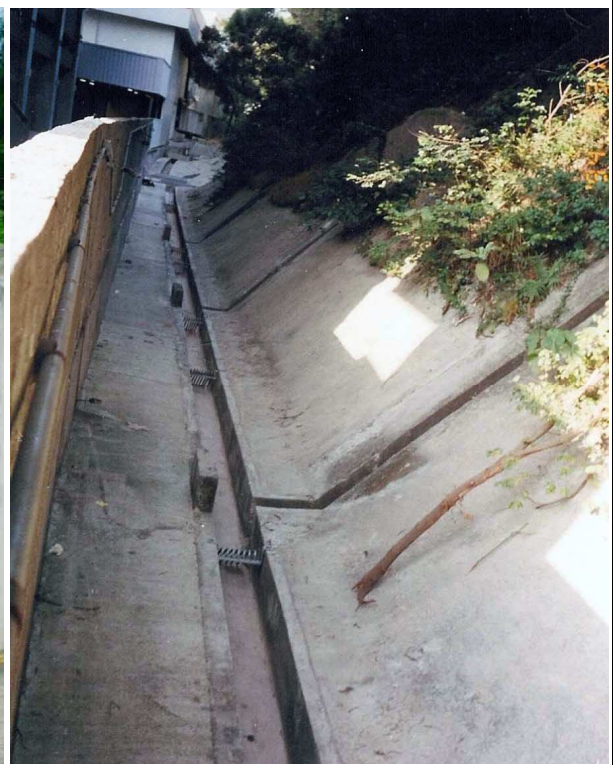
(2) 坡腳的 U 形排水渠
