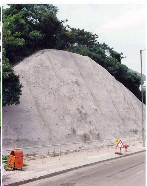
(2) 噴漿混凝土護面
