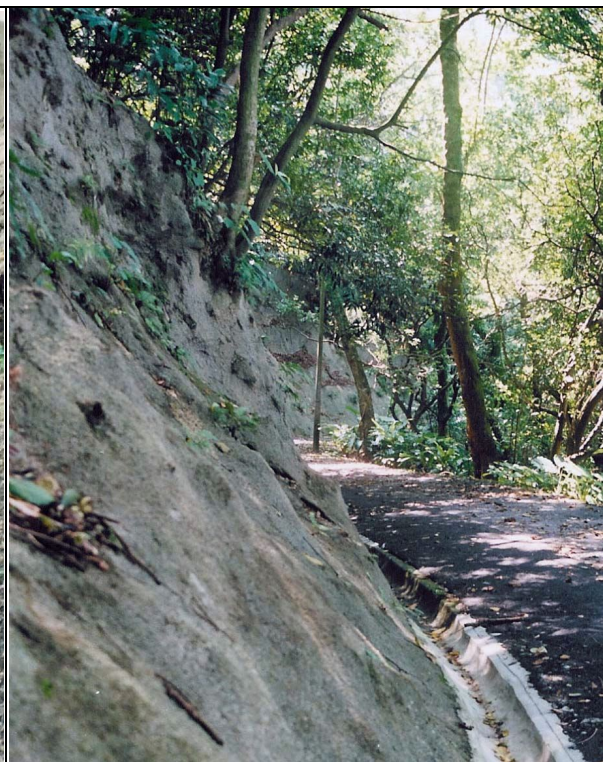
(2) 噴漿混凝土護面
