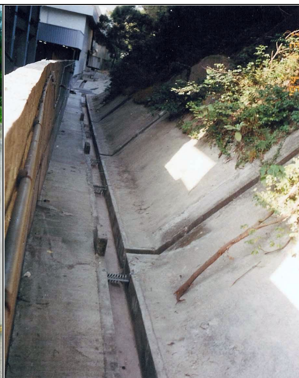
(2) 坡腳的 U 形排水渠
