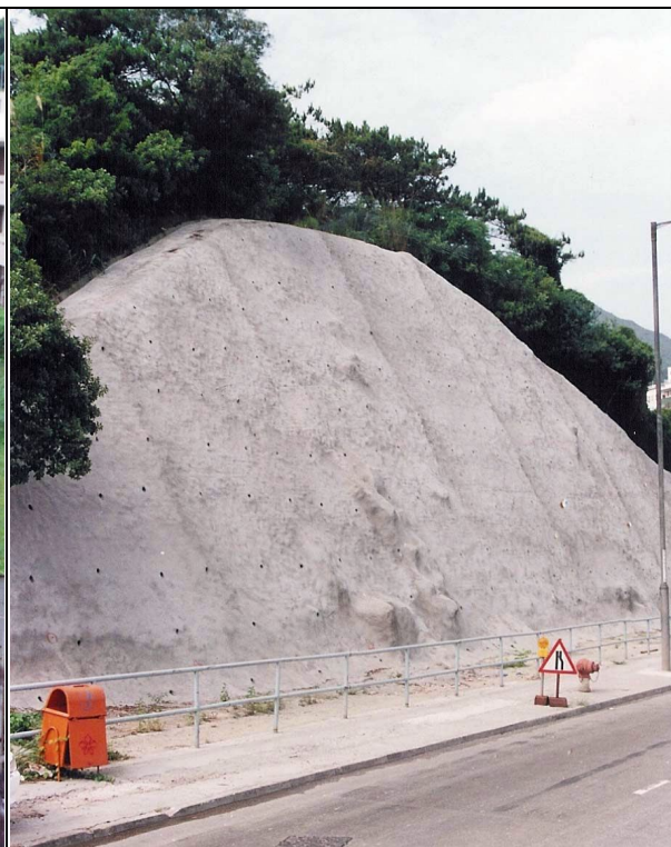
(2) 噴漿混凝土護面
