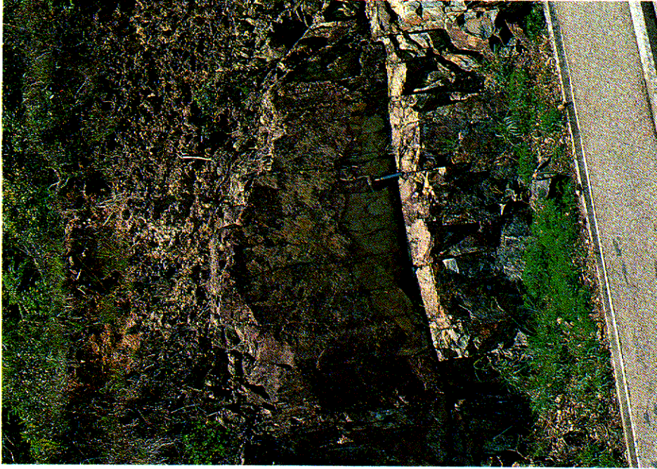
照片圖 1.8 - 顯示風化火山岩 B 帶上覆 D 帶的削上斜坡： A 帶和 C 帶缺失
