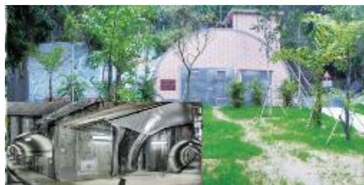
興建寶珊道地下水排放系統以控制地下水位，從而減低發生大型滑坡的風險
