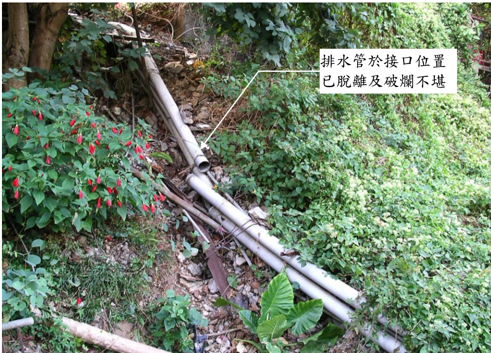
照片 11 - 伸延自登記寮屋編號RTW/4A/389, 391-393 的聚氯乙烯排水管 (照片攝於二零零五年十二月六日)
