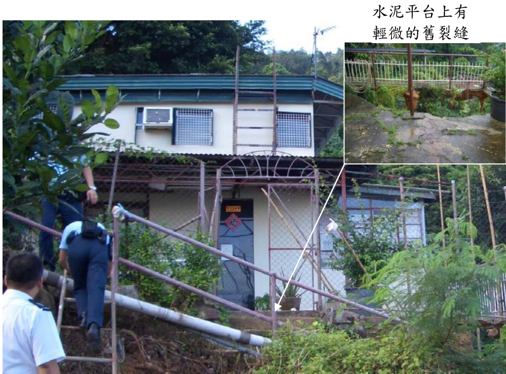
照片 4 - 位於滑坡斷崖上方的登記寮屋編號RTW/4A/388 (照片攝於二零零五年八月二十九日)
