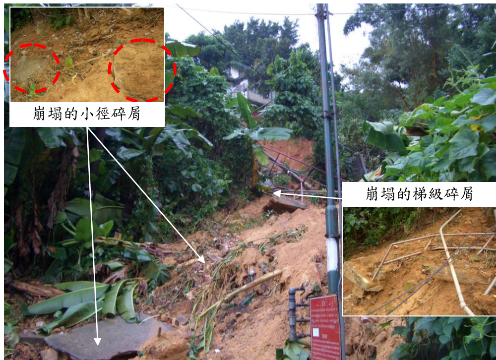
照片 15 - 滑坡泥石下部近滑坡腳的景像 (照片攝於二零零五年八月二十一日)
