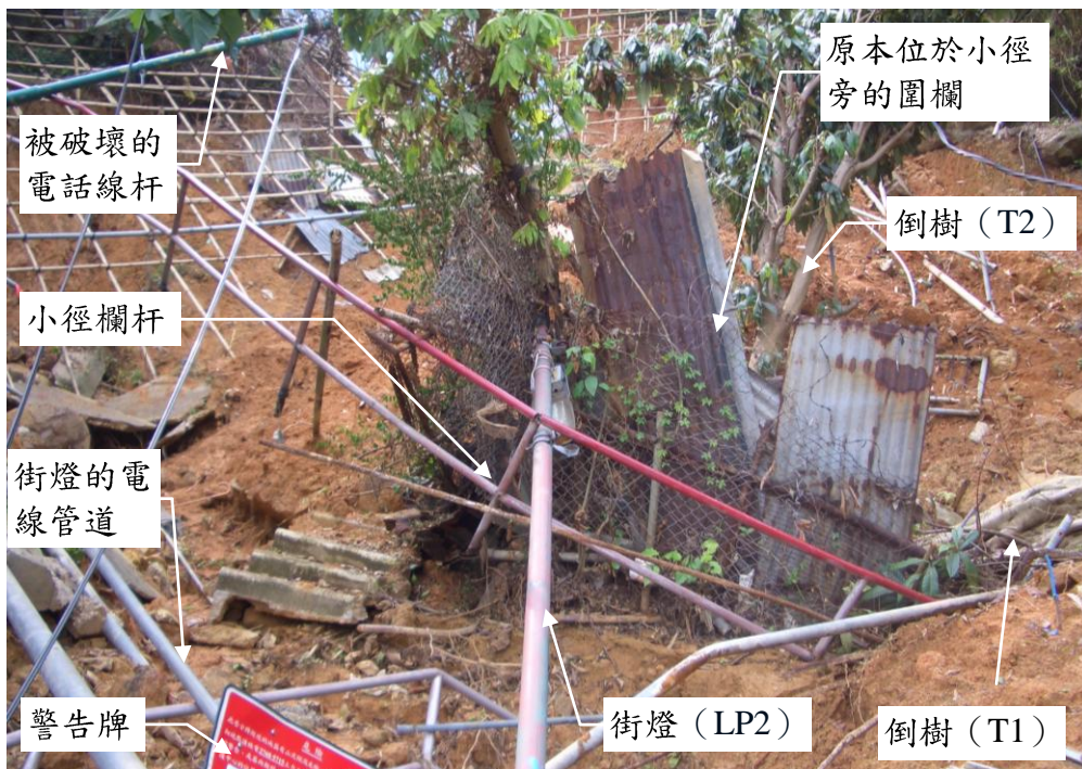
照片 17 - 街燈 LP2 位於小徑欄杆的下方 (照片攝於二零零五年九月七日)
