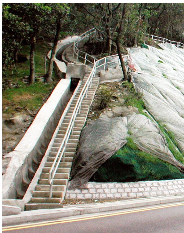
(4) 併合排水級渠的樓梯
