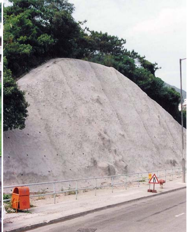
(2) 噴漿混凝土護面
