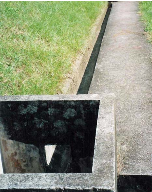
(3) U 形排水渠及集水井
