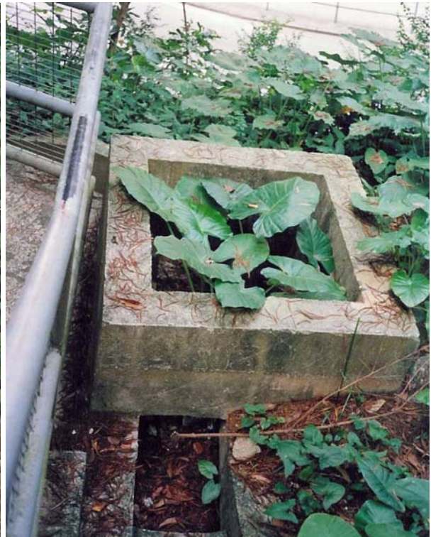
(4) 坡頂的集水井
