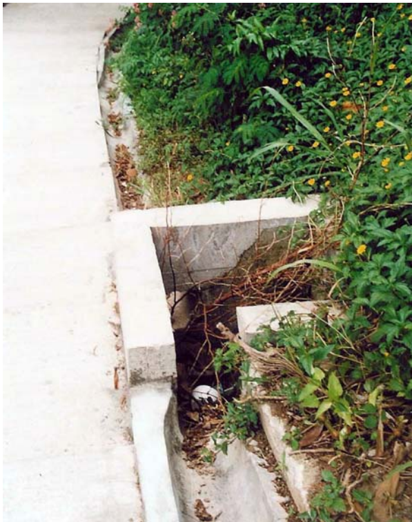
(3) 坡腳的集水井
