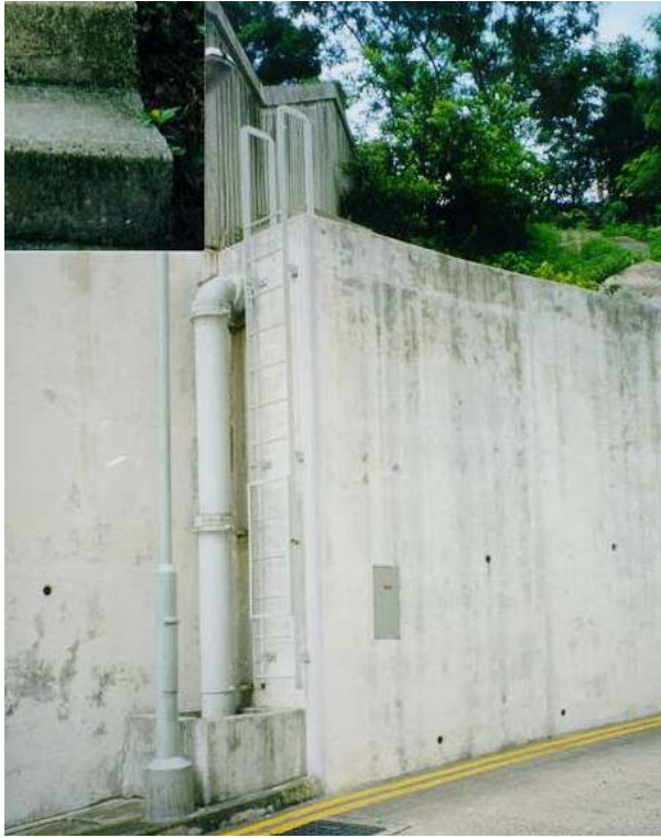
(1) 鋪設在擋土牆外的帶水管道
