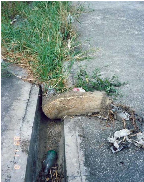
(1) 坡頂的 U 形排水渠
