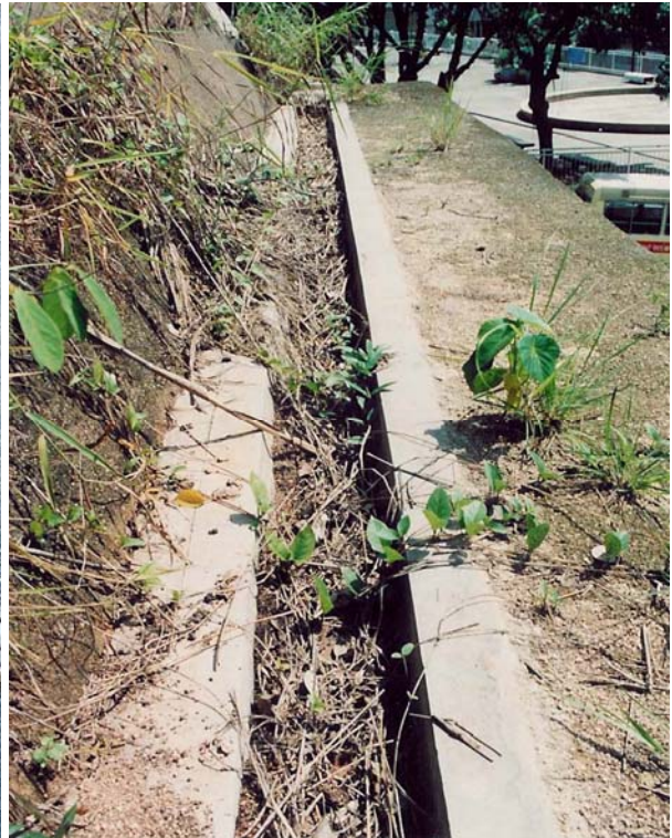
(2) 坡級上的 U 形排水渠
