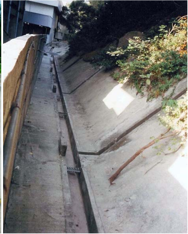
(2) 坡腳的 U 形排水渠
