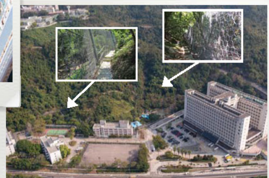
沙田醫院後面的柔性屏障
