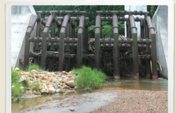
日本的泥石過濾結構(網架結構) - 相片由神戶製鋼所提供
