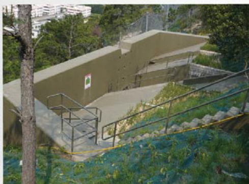
以鋼筋混凝土建造的剛性屏障
