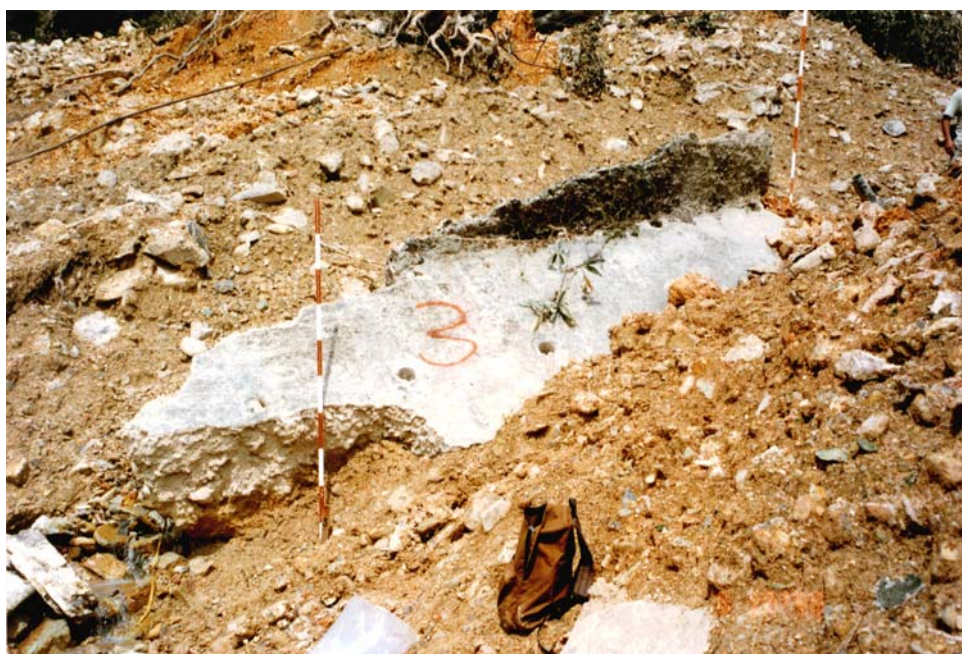
照片5 - 山泥傾瀉殘痕下部的擋土牆碎塊
