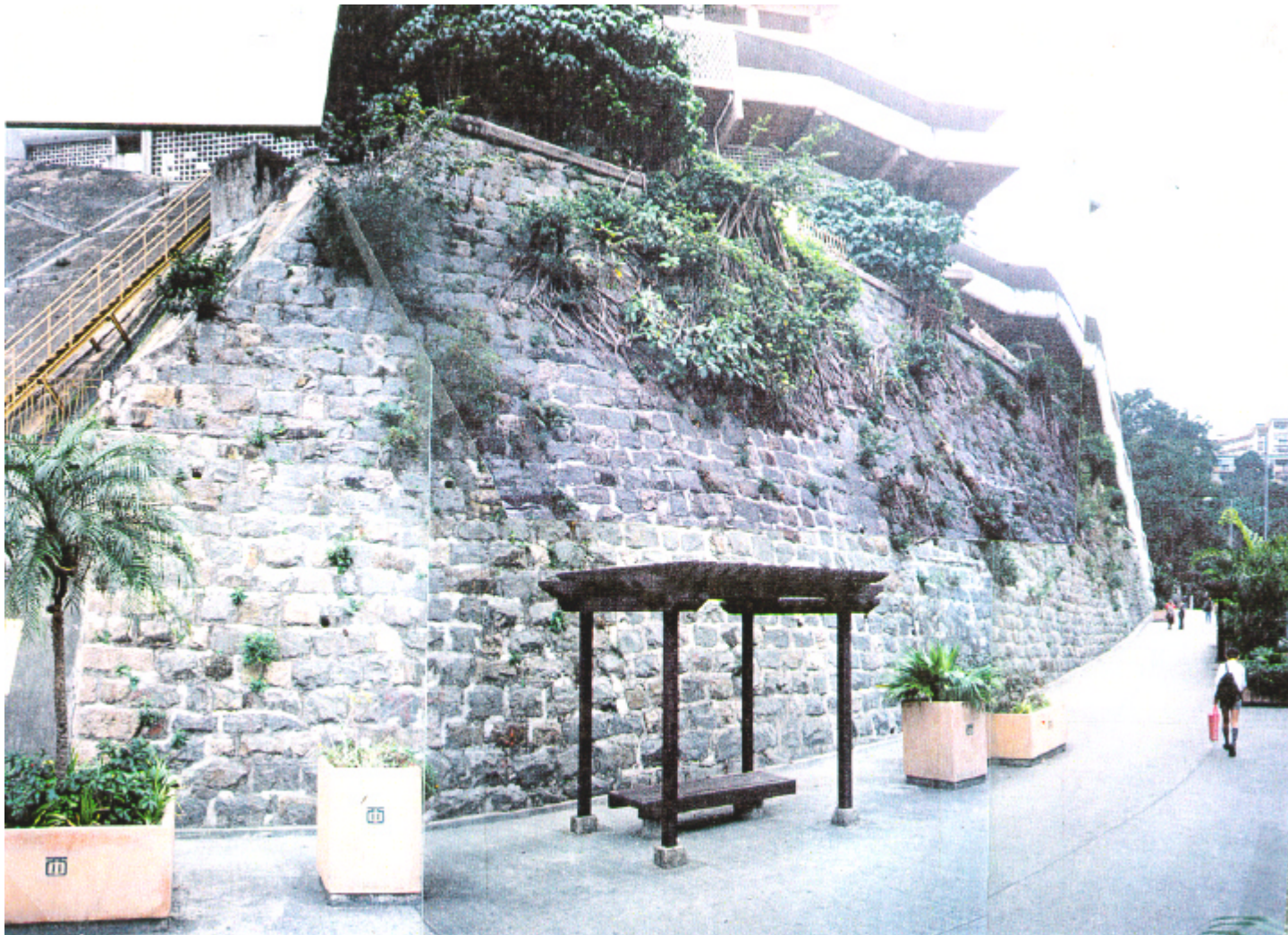
照片 M3 - 編號 11SW-A/R309 砌石牆，攝於一九九一年一月。
