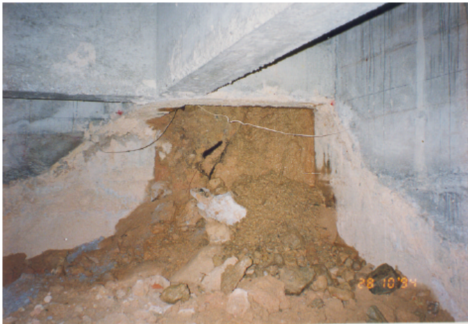
照片M15 - 於挖掘編號TP35探井後，院子範圍下面的泥土外露。 (院子範圍內編號BH12鑽孔在進行現場透水試驗時， 探井內的泥土塌下。照片攝於一九九四年十月二十八日)
