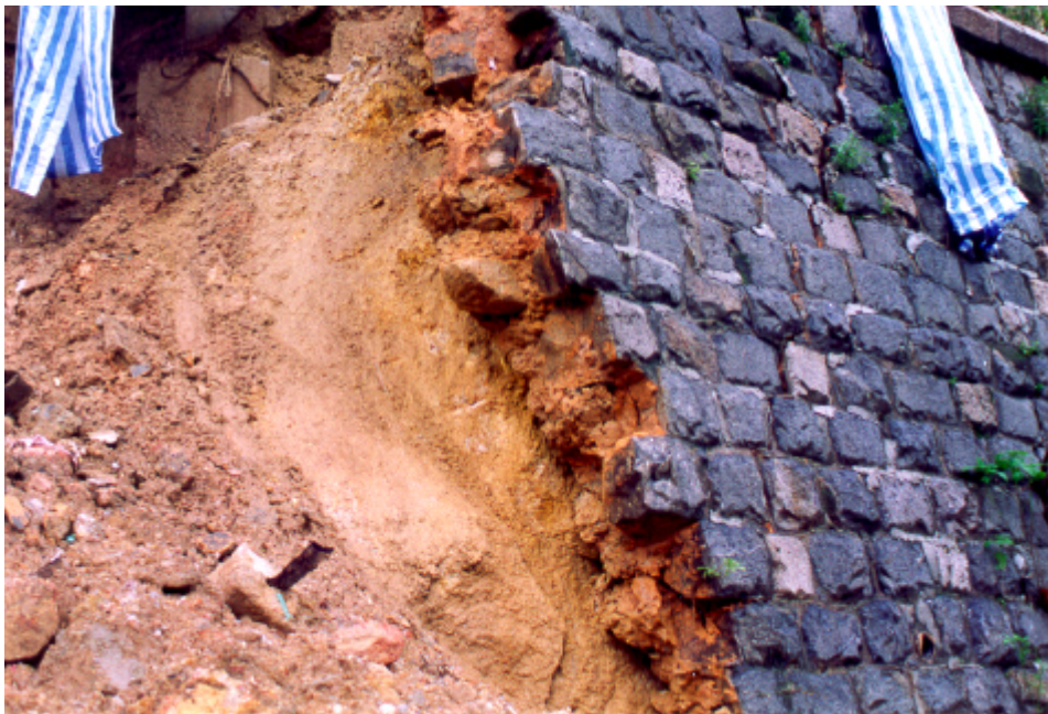
照片M9 - 鄰近山泥傾瀉範圍西面，未有塌下的砌石牆部份。 (照片攝於一九九四年七月二十五日)
