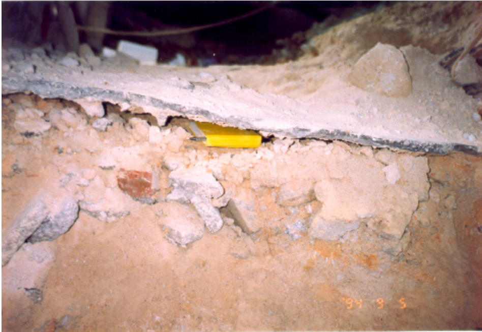
照片M16 - D座底部近地面的疏鬆填土(照片攝於一九九四年九月五日)。
