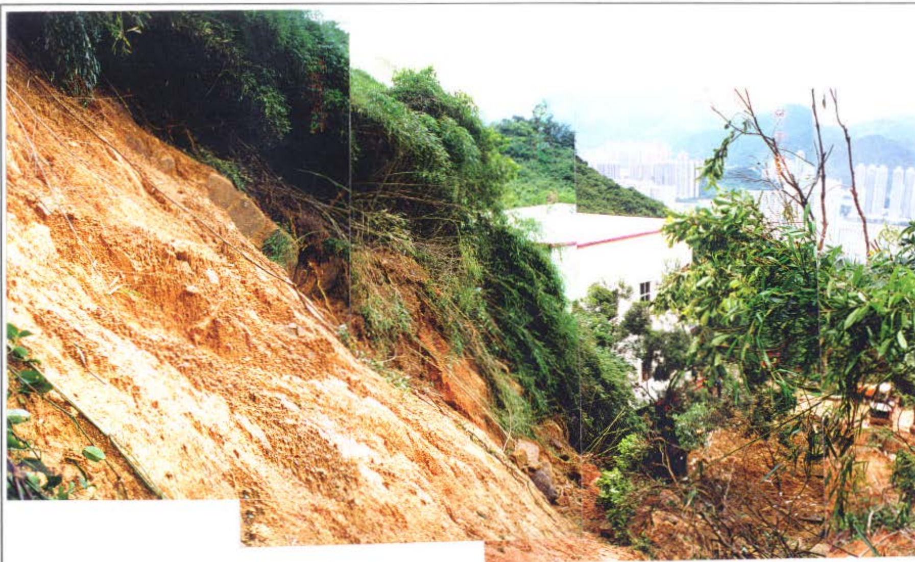
照片4 - 面狀節理面的景象(一九九七年七月七日拍攝，其位置見圖14，注意山泥傾瀉的東北翼與天然斜坡結合成一體 )
