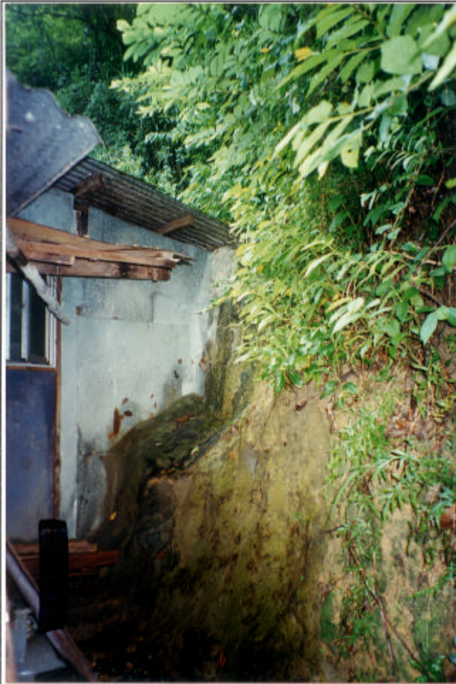
照片2 - 九華徑上村 26 號寮屋東側房角嵌入了編號為 11NW-A/C416 的削坡 (一九九六年八月二十二日拍攝，翻印自賓尼所做的SIRST報告，其位置見圖14)
