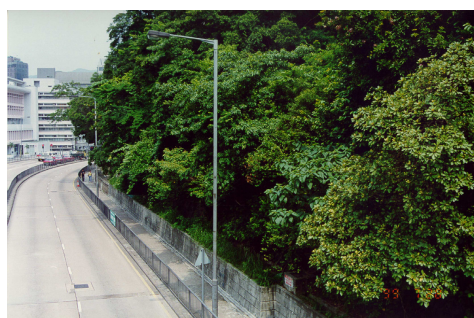
鞏固工程完成後
