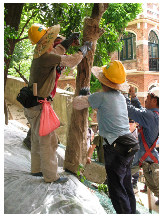
圖一：保護原有樹木措施 - 在施工期間以麻布包裹現存樹木作為保護
