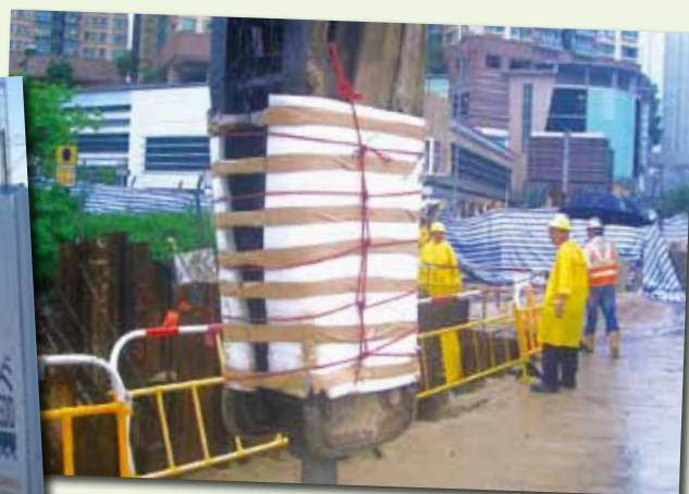
荃灣大河道與馬頭壩道之間一段楊屋道的擴闊工程
