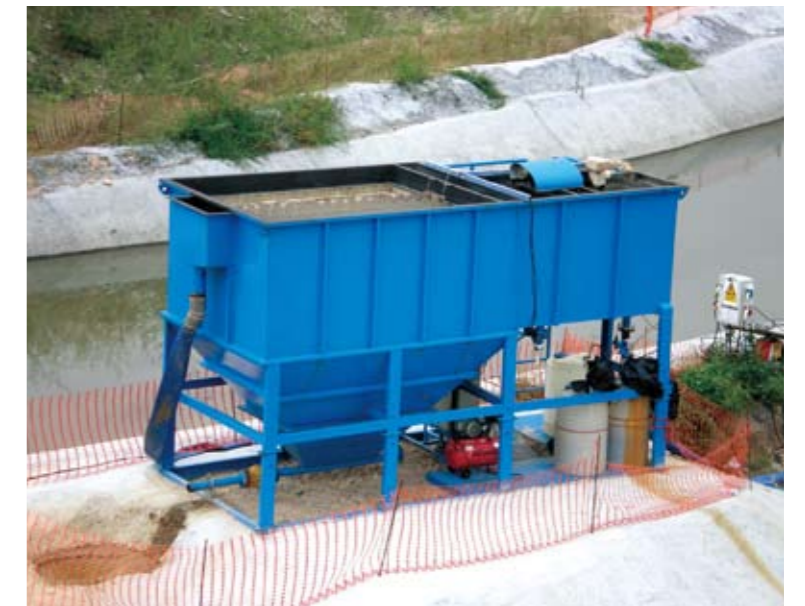
利用沉澱池處理地盤產生的廢水 Sedimentation tank to treat the wastewater generated on site
