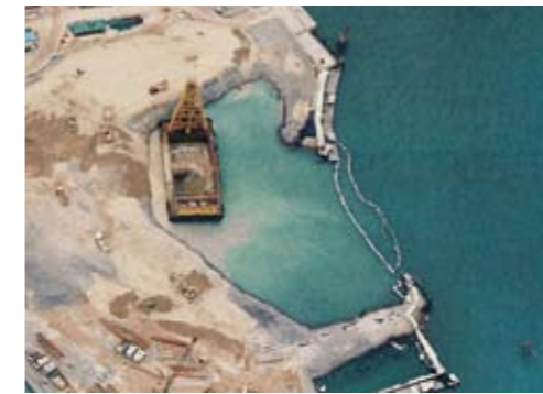
在淤泥屏障內進行填沙工程以防止泥沙流出工地 Sandfilling within silt curtain to prevent dispersion of silty plume
