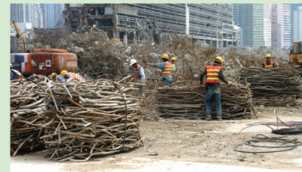
分類處理拆卸物料以供循環再用 Sorting of demolition materials for recycling
