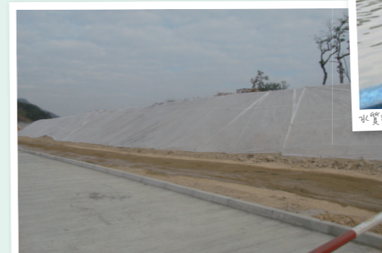
在開挖的土坡面覆蓋防塵網 Dust-suppression cover on excavated slope face
