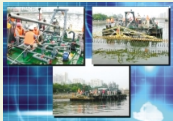
生物除污工程船 Bioremediation Barge
