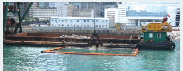
在淤泥屏障內進行填石工作 Rock filling within silt screen
