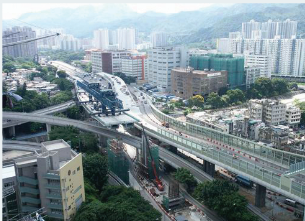
T3號道路 - 預製及預先裝嵌式建造 Road T3 - Precast and Pre-fabricated Construction
