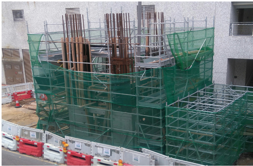
使用可重用的金屬棚架 Adoption of Reusable Metal Scaffold
