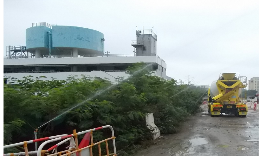
使用自動灑水器以抑制塵埃產生 Use of Automatic Water Sprayer to Suppress Dust Generation
