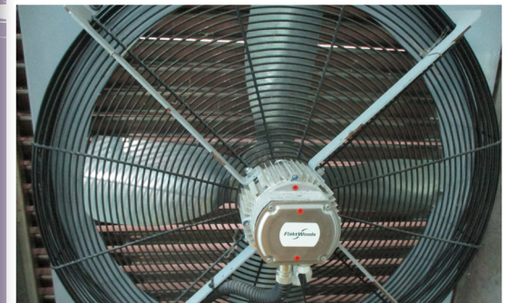
採用機械式通風升降機，以取代舊有的空調系統設計 Adoption of Mechanical Ventilation System for Lifts Instead of Air-Conditioning
