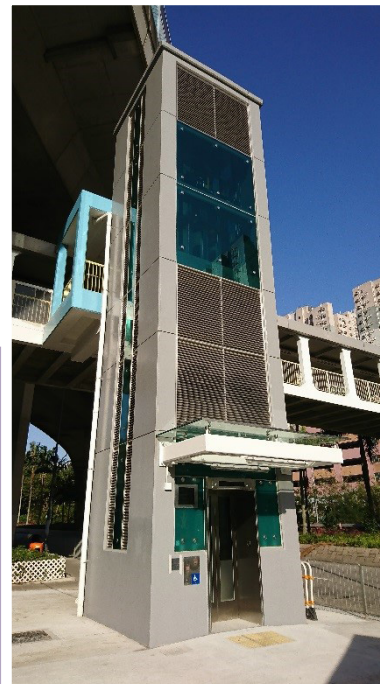
採用機械式通風升降機，以取代舊有的空調系統設計 Adoption of Mechanical Ventilation System for Lifts Instead of Air-Conditioning
