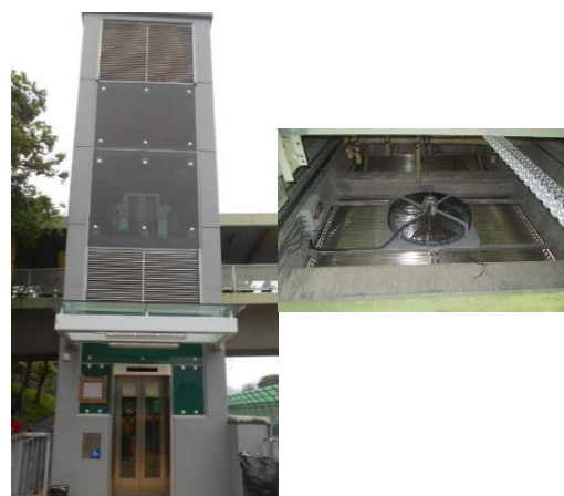
暢道通行工程
