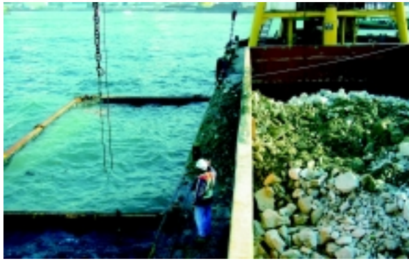
在隔泥幕內進行填海工程(填料來自其他政府工程挖出的剩餘物料) Filling within Silt Curtain (using surplus excavated material from other government projects)
