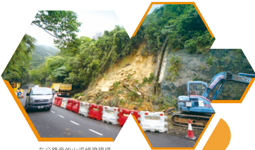
在公路旁的山泥傾瀉現場 A roadside slope failure
