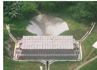
Plate (d) - Debris-resisting barrier with 600 \text{ m}^3 design debris retention volume
