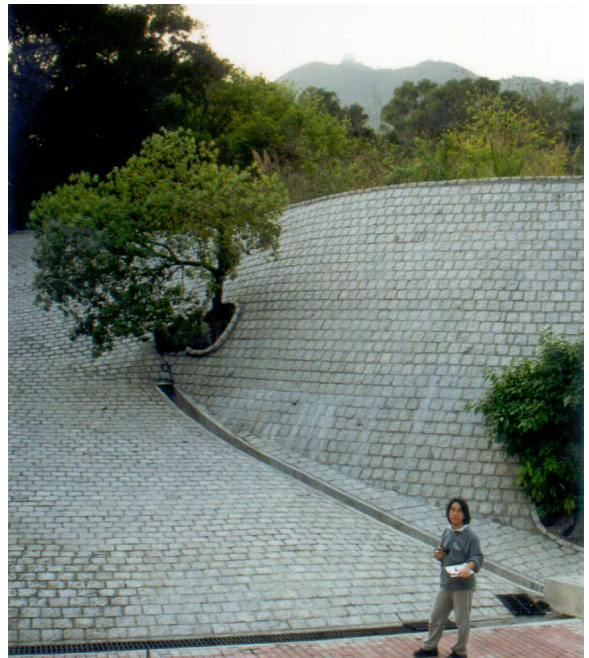
(d) block surface cladding used on fill slope
