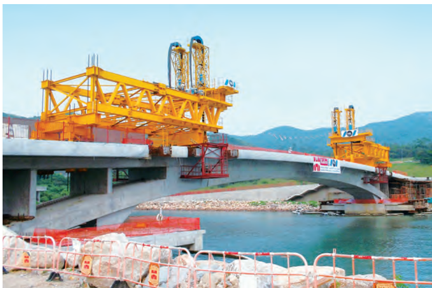
放置橫跨東面水道的單車及行人橋的預製主橋身
