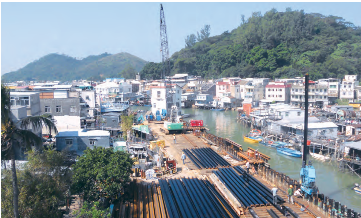
大澳河堤打樁工程進行中 Riverwall piling works at Tai O
