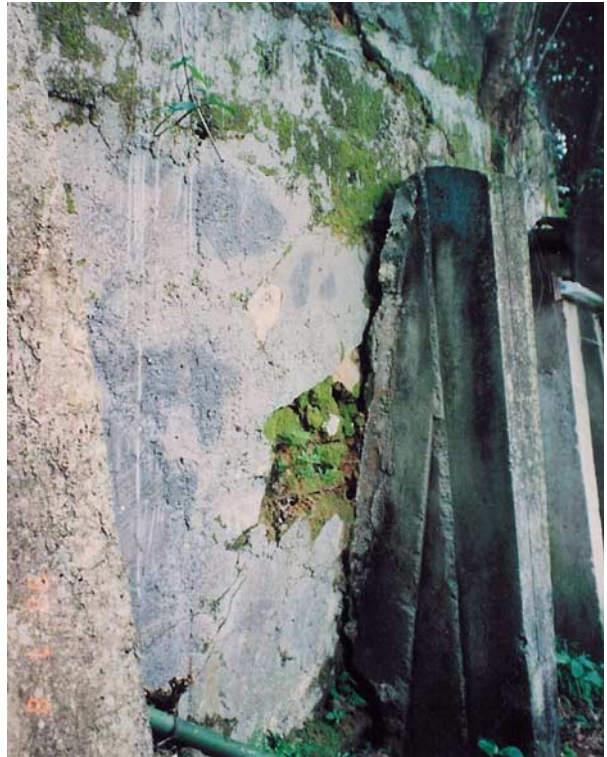
(d) Cracked Surfacing and Wall
