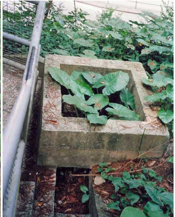
(d) Catchpit at Crest of Slope
