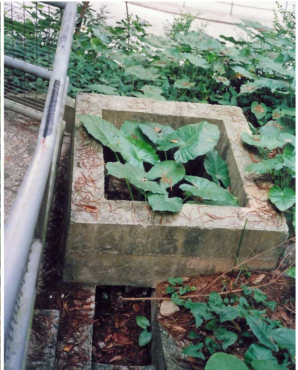
(d) Catchpit at Crest of Slope
