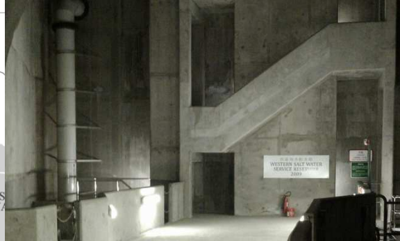
香港大學的西區海水配水庫 (2009)
