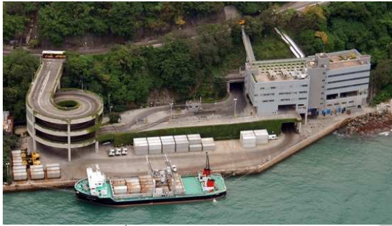
港島西垃圾轉運站 (1997)
