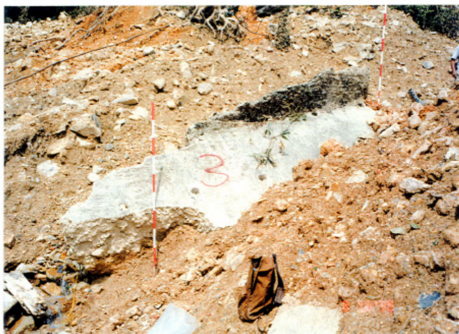
照片 5 - 山泥傾瀉殘痕下部的擋土牆碎塊
