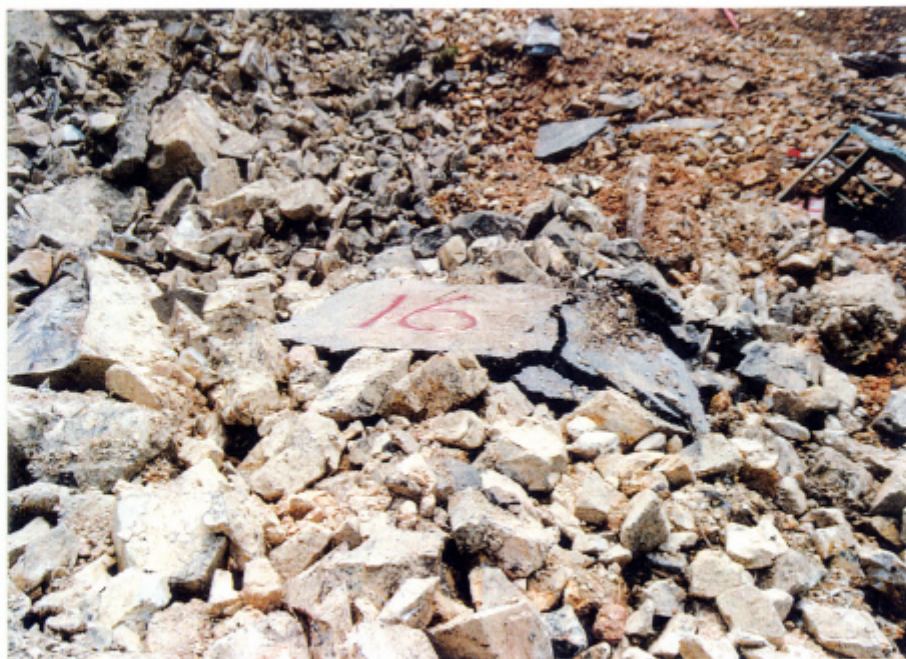
照片 6 - 山泥傾瀉殘痕上部的瀝青路面(1.5 米 x 1 米)
