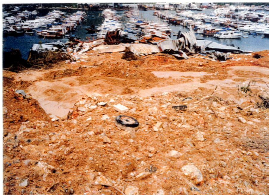
照片 4 - 在山泥傾瀉殘痕上帶有填料及廢料的泥石
