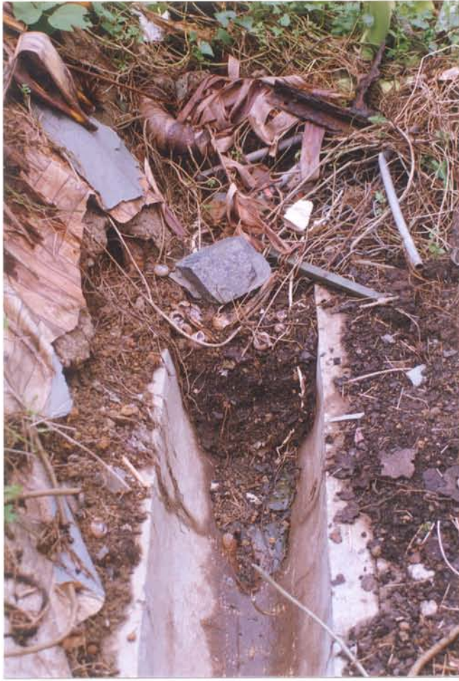
照片 4 - 削坡未崩塌部份 的淤塞地面排水渠 (一九九五年十月十日 拍攝。其位置見圖 21)
