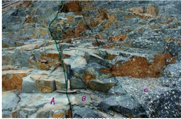
岩牆與圍岩的接觸關係 A - 大嶼山花崗岩, B - 冷凝邊, C - 長石斑岩
