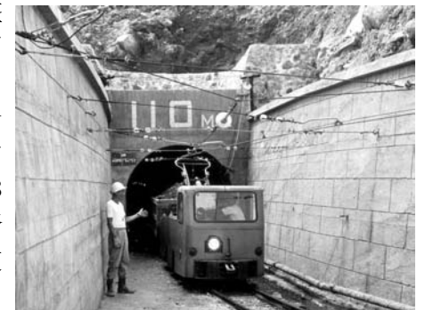
110米主輸礦隧道出口
