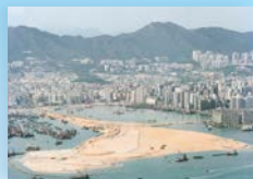
西九龍填海工程 West Kowloon Reclamation
