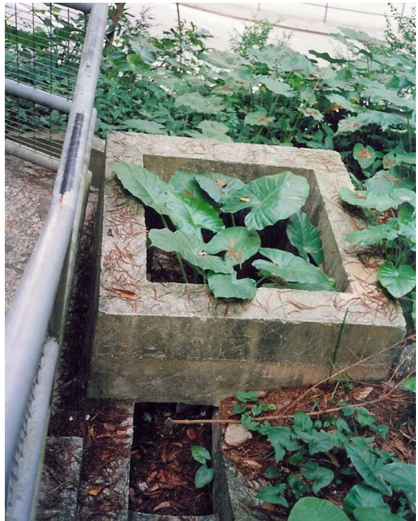
(d) Catchpit at Crest of Slope
