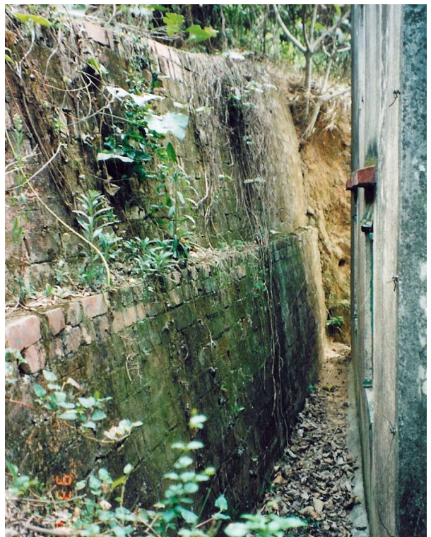
(d) Masonry Facing
